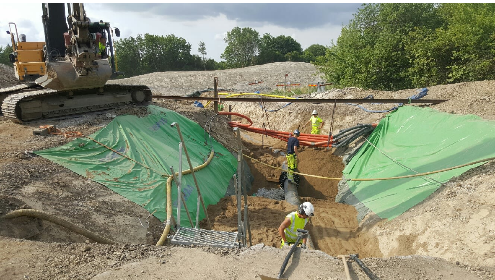
Inkoppling av dricksvattenledning i Lund 16 juni 2018
